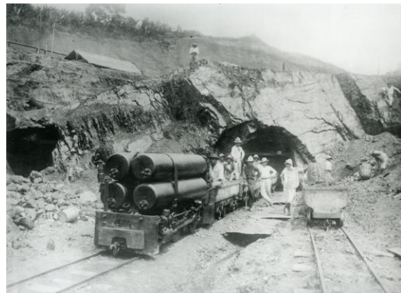
Een persluchtlocomotief verlaat een galerijmijn van de Boekit Asammijnen. Nationaal Museum van Wereldculturen (0004 0779)
