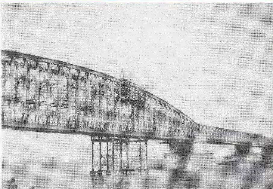
De brug met noodondersteuning, tijdens de reparatieperiode na de oorlog. Bron: Ing. Mallon, Nederlandse Spoorwegen.
