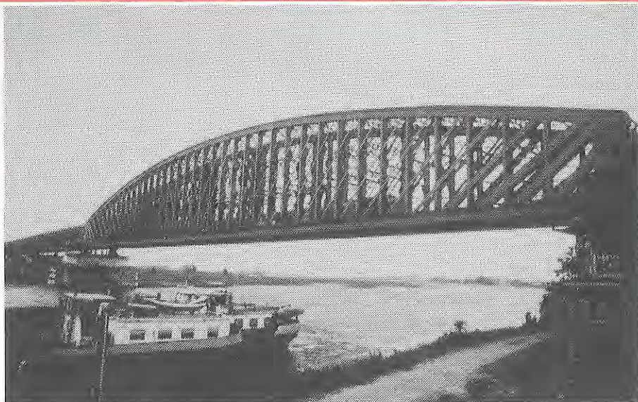
De grote overspanning met drievoudig vakwerk.
