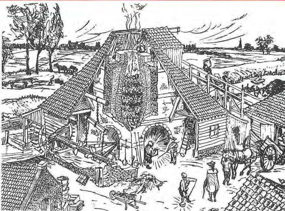
Ulfse hoogoven om erts uit ijzeroer te maken in de 18e eeuw – Tekening J.J. Arentsen.
