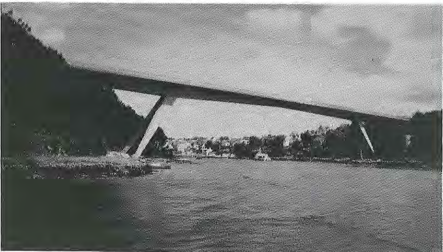
Pont de Kernours, nabij Vannes in Bretagne. Betonnen kokerliggerbrug, 1968. Overspanning 147 m.
