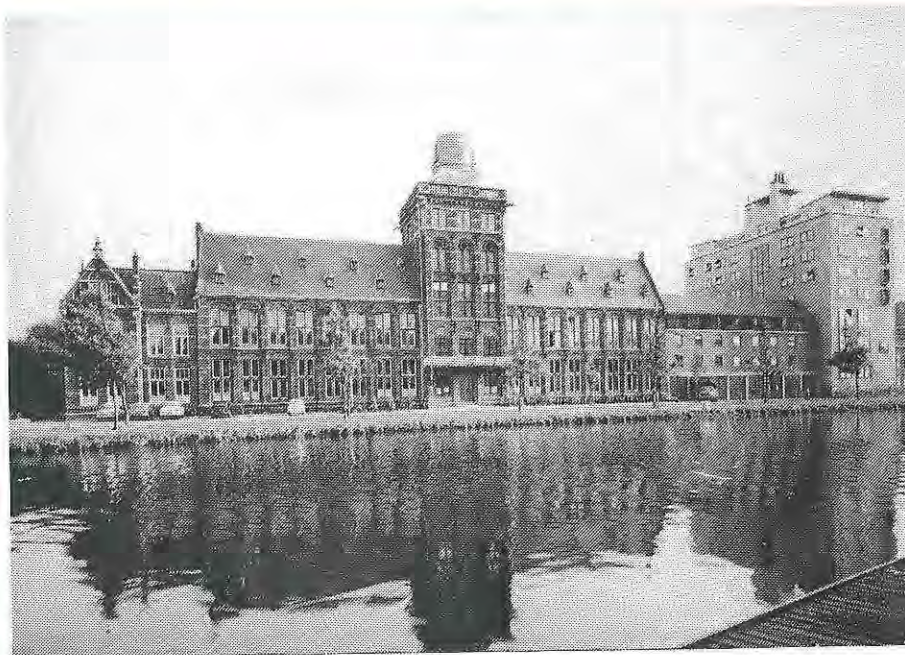
Het fraaie TTC-gebouw aan de Kanaalweg te Delft
