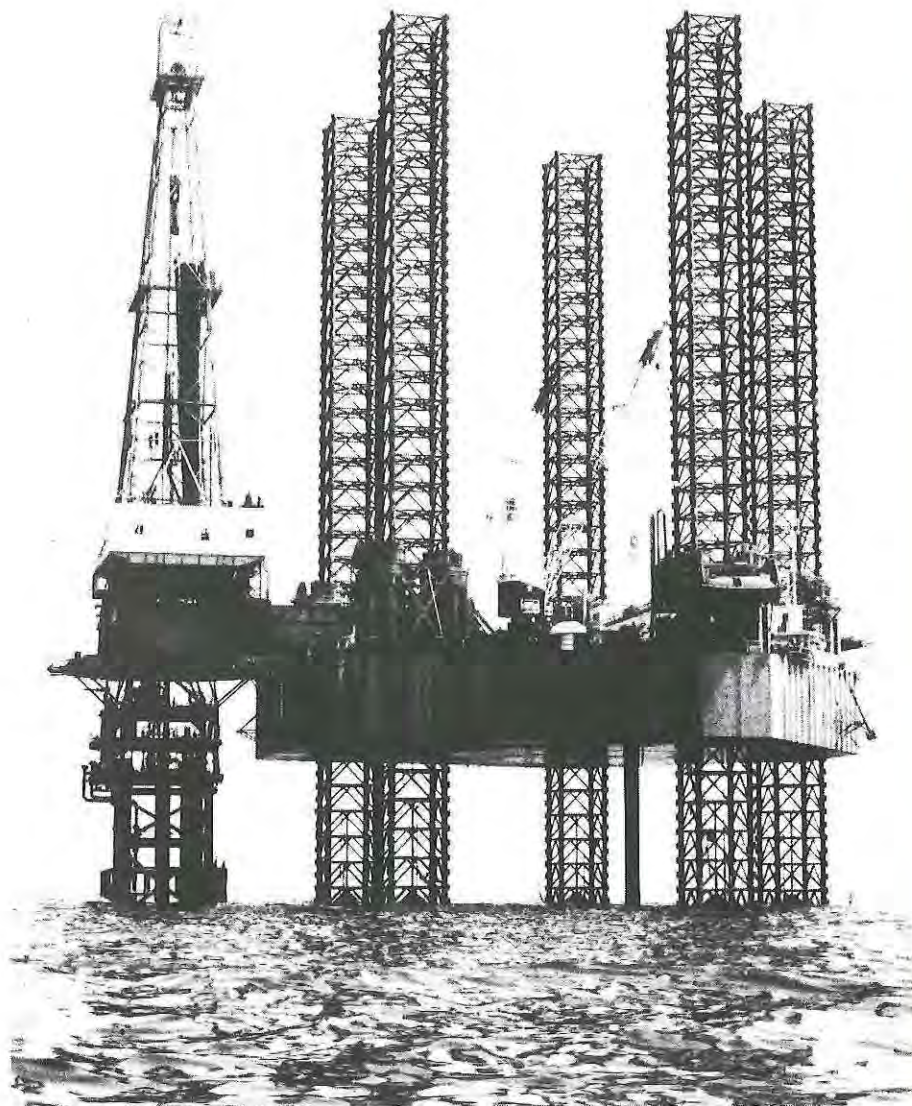
Fig. 4. Jackup-platform met boortoren. Boorwerkzaamheden worden verricht boven een klein puttenplatform.
