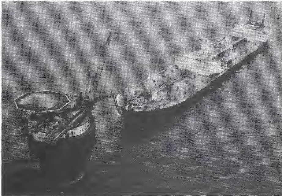
Brent Spar opslagtank met afgemeerde transporttanker. De opslagtank is 120 m hoog en heeft een capaciteit van 300.000 vaten.
