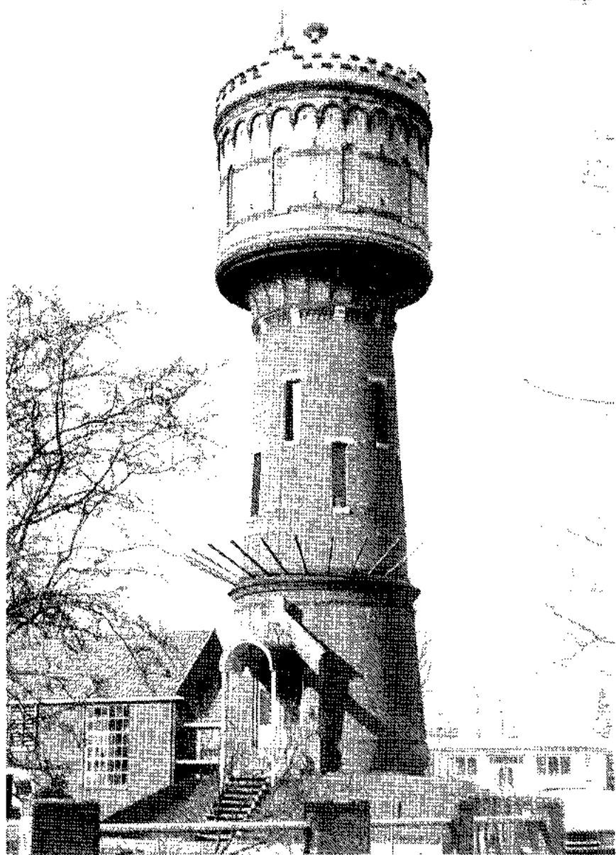
Afb. 13 — Watertoren te Woerden, bouwjaar 1906, bestaat nog, ontwerp J. Schotel. IJzeren reservoir type Intze, inhoud 75 m 3 .
