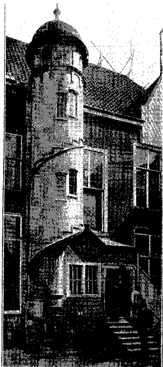
Afb. 18 -- Betonnen traptoren van het gebouw De Club te 's-Gravenhage, 1895. L.A. Sanders, Het cement-ijzer in theorie en practijk, Amsterdam, 1907.
