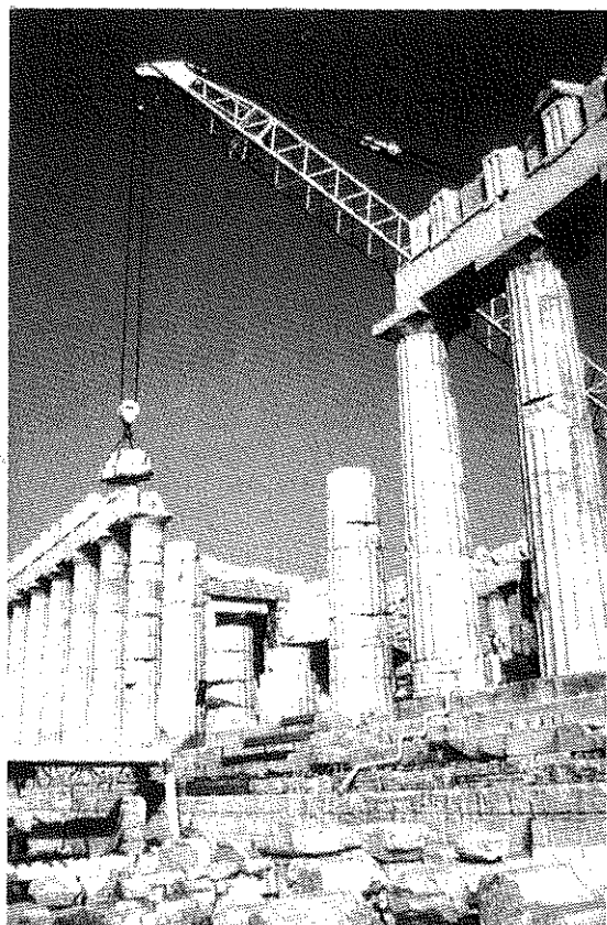
De kraan in gebruik bij de bres in de zuidzijde.
